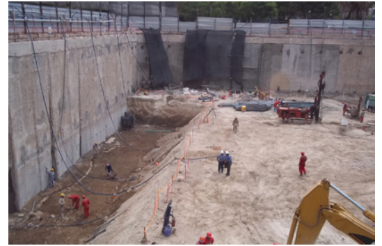
Freyssibar micropiles - Saint Régis Hotel - Argentina
