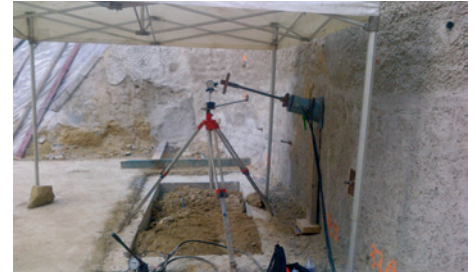
Soil nail tests, Méliá tower, La Défense
