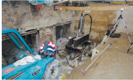
Micropile tests, Méliá tower, La Défense
